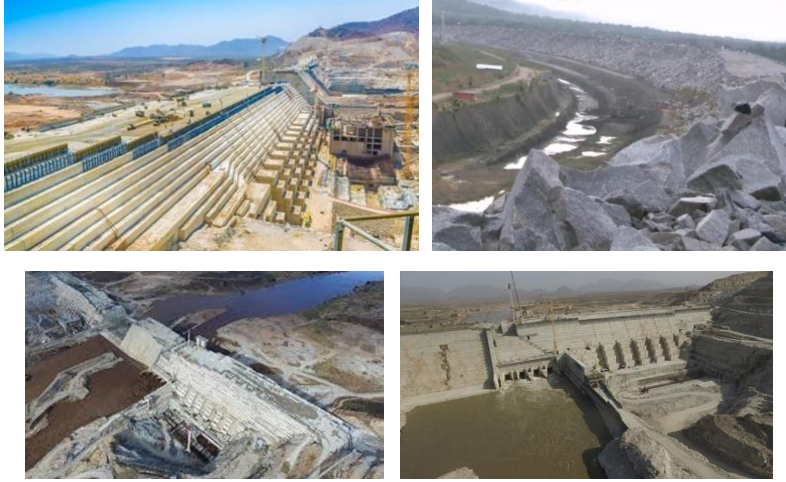
شكل ٢. تقدم البناء في سد النهضة وسد السرج المساعد في ٢٠١٧
